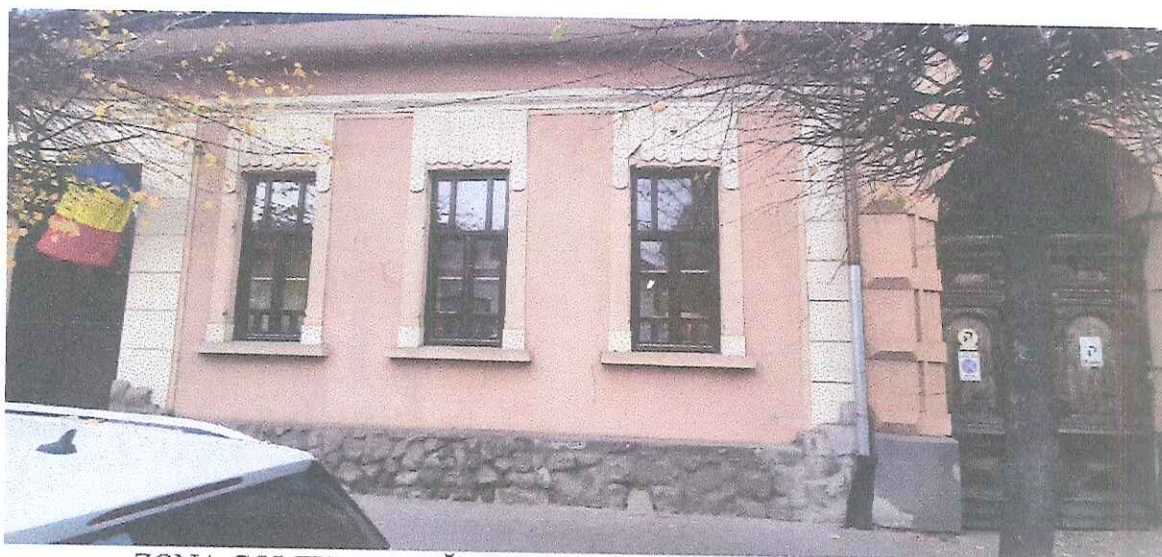
ZONA COLȚULUI CLĂDIRII ȘI PERETELE VECIN DE LA NR. 30
