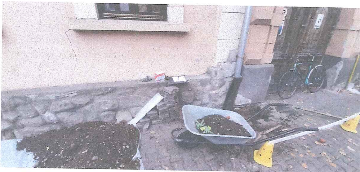
SONDAJ LOCAL LA FUNDATIE
