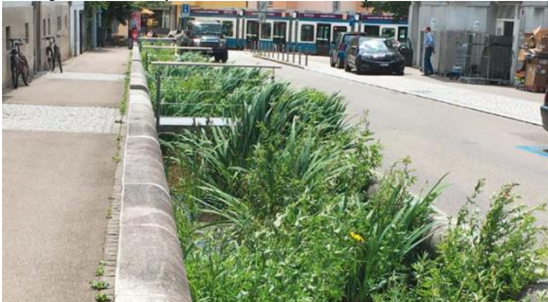
Figura 23. Curs de apă canalizat, readus la lumină: p.Nebelbach din Zurich
