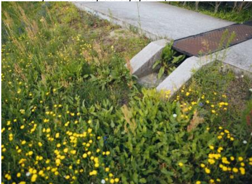
Figura 18. Exemplu de rezolvare preluare ape pluviale, adiacent str. Adlershof, Berlin
