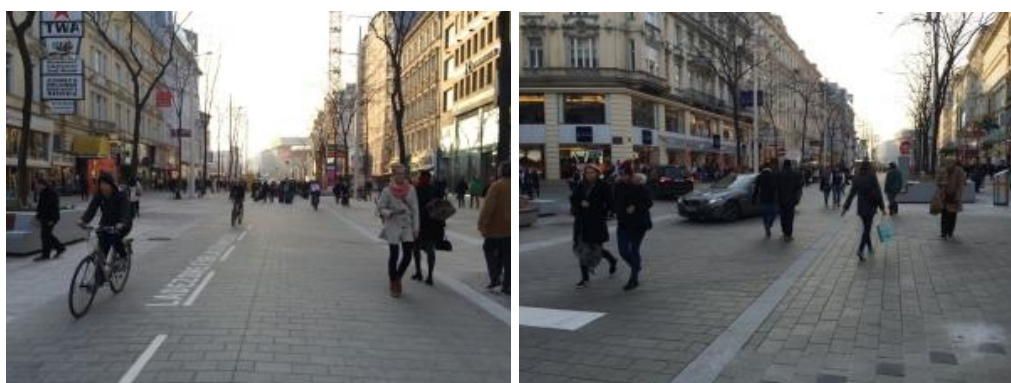
Marcaje in pavaj, statii de taxi si alte elemente generează confuzie și iau din spațiul pietonal, acordându-l mașinilor
