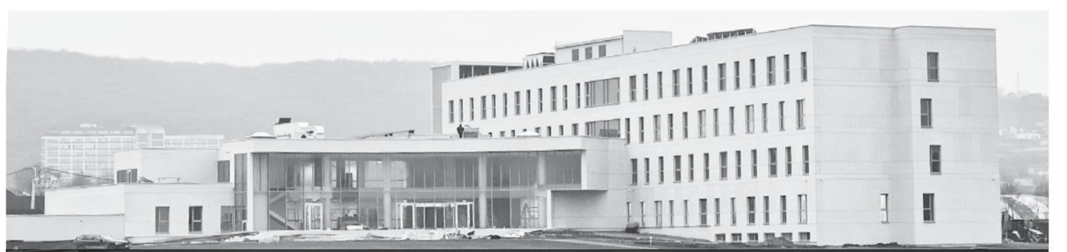
Șantierul Spitalului Oncologic Medex
