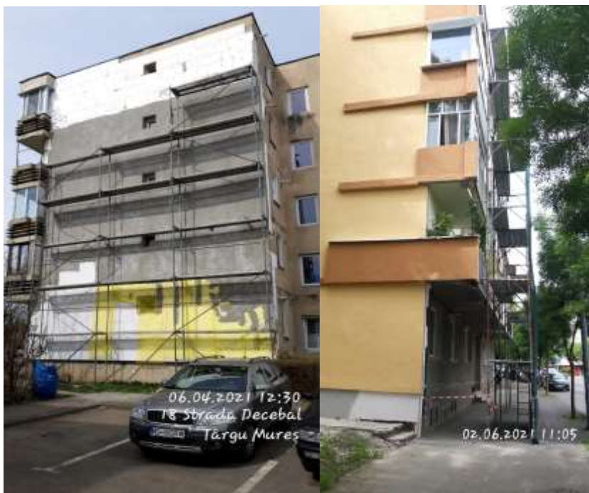
Lucrări de reabilitare energetică a clădirilor de locuințe colective
